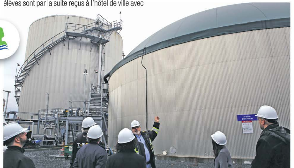
La MRC de Marguerite-D'Youville a été sélectionnée avec les MRC de la Vallée-du-Richelieu et de Rouville pour la création du Centre de traitement des matières organiques par biométhanisation de Varennes.
