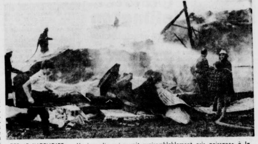
FERME INCENDIÉE — Un incendie qui aurait vraisemblablement pris naissance à la suite d'une défectuosité du système électrique a complètement rasé au sol une grange-étable et une laiterie du 10e rang de Ste-Jeanne-d'Arc près de Wickham. Il s'agit de la ferme de M. Damien Béchard. Les pompiers de Wickham et de L'Avenir se sont rendus sur les lieux mais ils n'ont pu protéger la résidence puisque les autres bâtiments étaient complètement en feu à leur arrivée sur les lieux. (Photo La Tribune, Drummondville)
