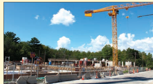
Les travaux sont commencés sur la rue Liénard, tout près des anciennes installations de TVA.
