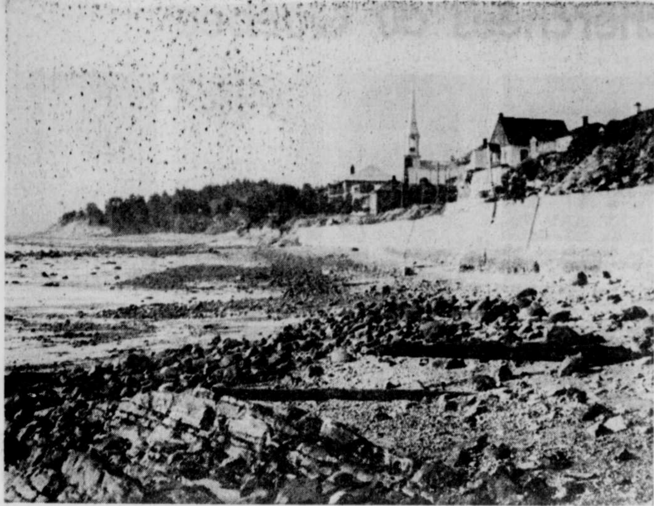
Une route à quatre voies passera sur cette grève, en direction de Pointe-au-Pic.
