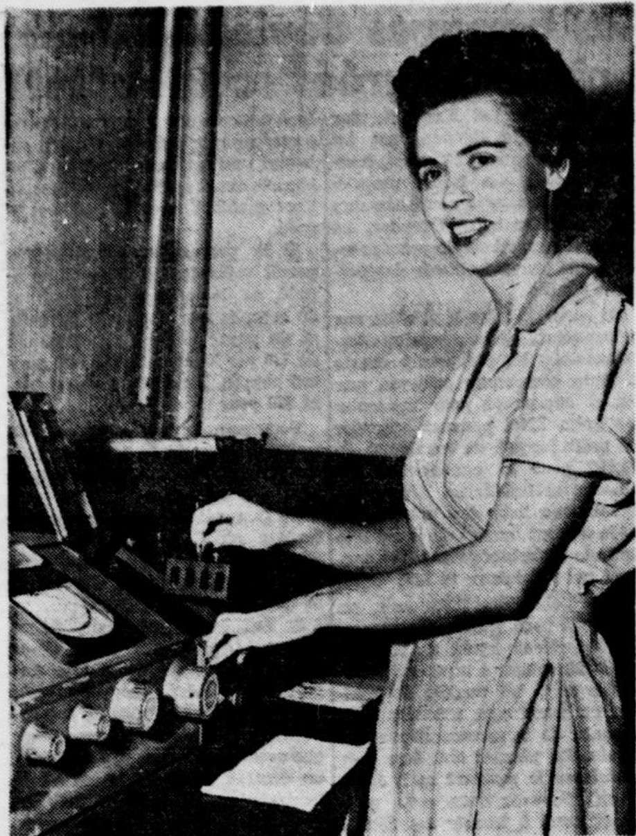
MLLE MARTHE TREMBLAY, analyste au laboratoire principal depuis plus de six années, se sert ici du spectrophotomètre. Elle se prépare à introduire dans l'appareil, quatre cellules contenant les échantillons à être analysés.
