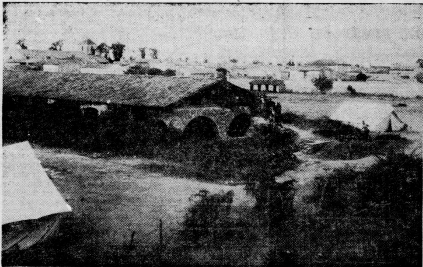
LA FORTERESSE, construite par l'ingénieur d'Argencourt, affectait la forme d'un carré irrégulier de 400 mètres environ de côté, flanqué de sept bastions et surmonté d'échauguettes dont la plupart existent encore de nos jours. Richelieu avait fait construire à grands frais un arsenal, une caserne, un hôpital,
