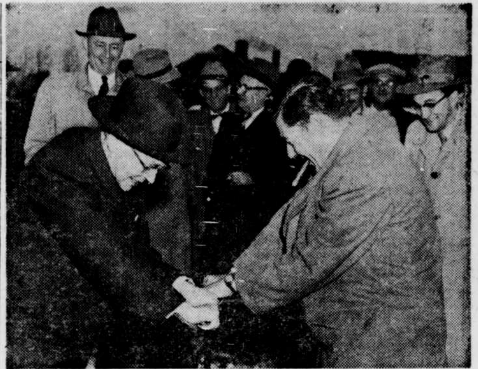
RIVERBEND PREND SON EAU DE L'AQUEDUC D'ALMA — En vertu d'un nouveau contrat entre les villes d'Alma et de Riverbend trois municipalités sont maintenant alimentées par un seul aqueduc. On assiste ici à la scène typique de l'ouverture de la valve maîtresse, par les maires R. Maloney, de Riverbend et Paul Levasseur, d'Alma. Au second plan nous remarquons M. C.-A. Locke, gérant général de la compagnie Saguenay Power.
