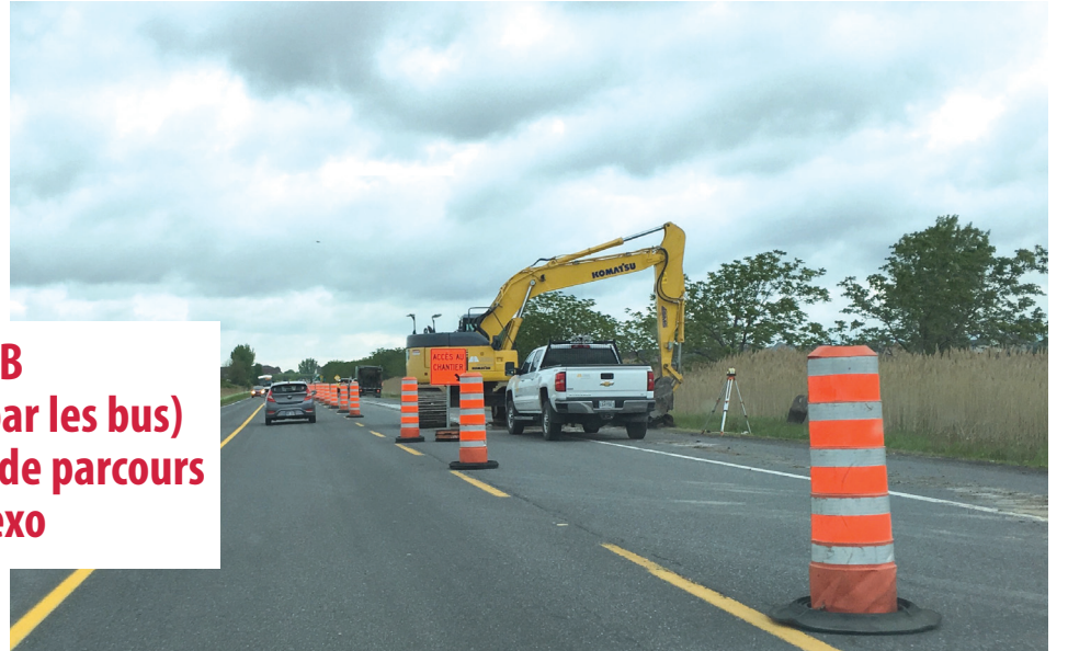
Les travaux ont débuté le 5 juin. (Photo : Martine Veillette)
