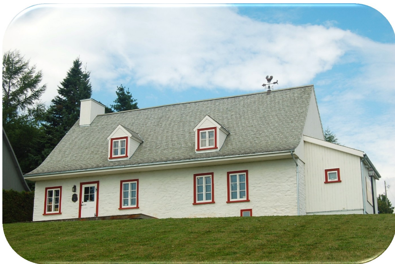
Maison Vézina, Boischatel
