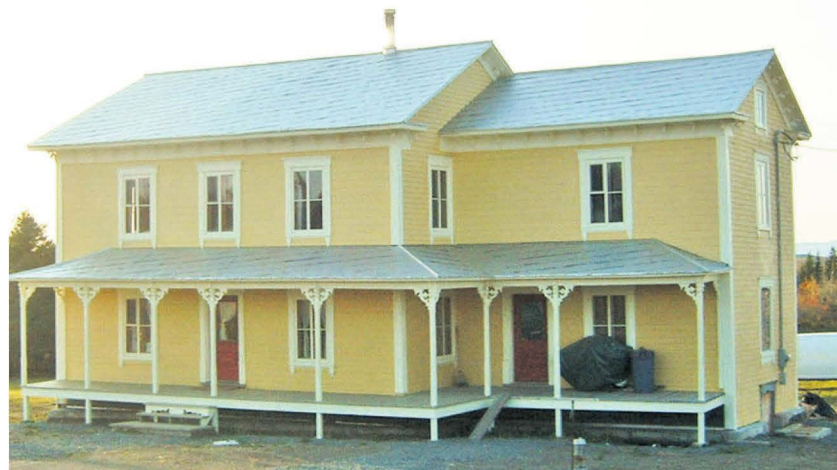
La maison Ouellet à Sainte-Hélène est un bel exemple de restauration réussie. Photos : MRC de Kamouraska
