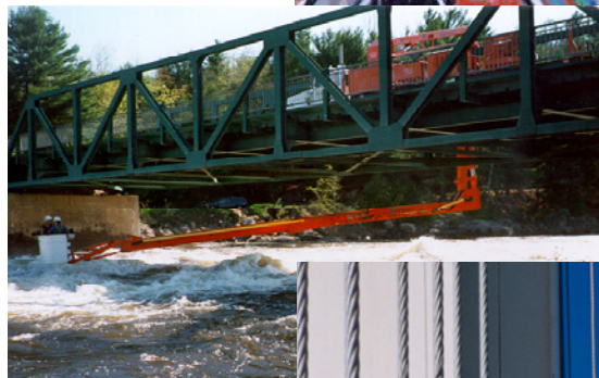
Inspection à l'aide de la nacelle
