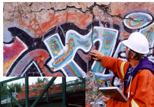
Inspection « le doigt sur la pièce »
