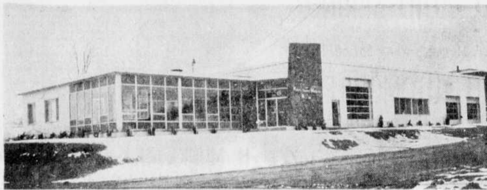
Vue extérieure d'une partie de notre manufacture.
