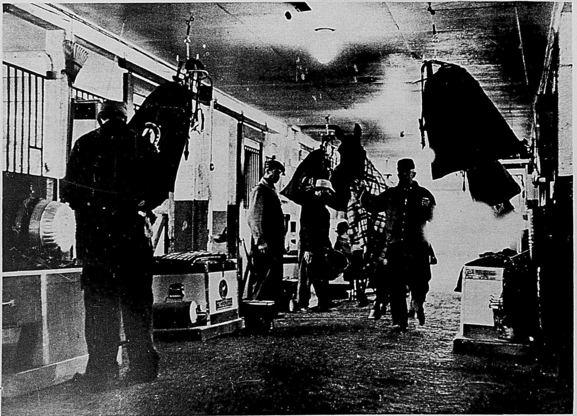
L'intérieur des bâtiments, propre, éclairé
