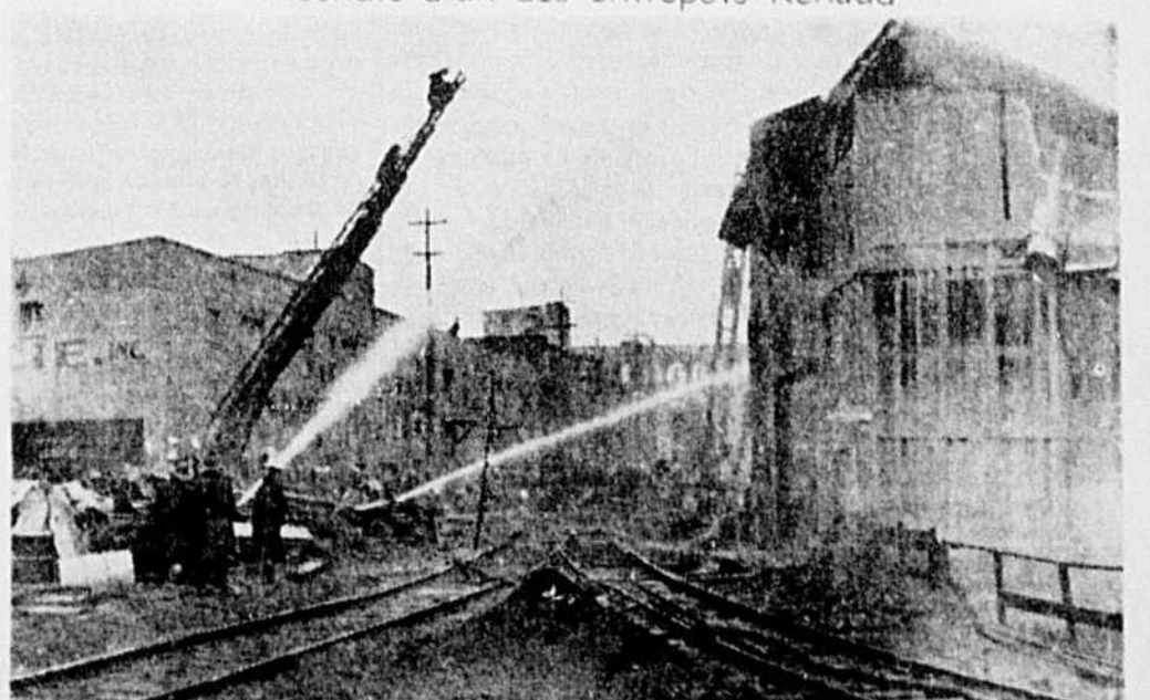
Incendie d'un des entrepôts Renaud
