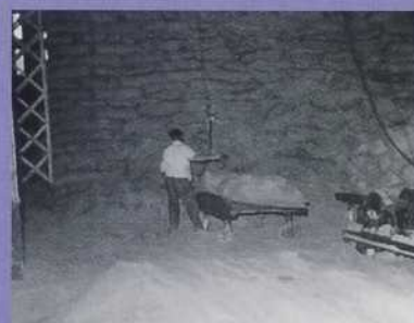
1957. Entreposage du sucre brut.
