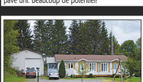
Situé près du Théâtre des Grands Chênes à Kingssey, terrain plus ou moins 40 000 p.c., bordé par petite rivière, 4 c. à c., garage double 16 pi hauteur.
