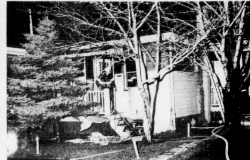
La petite maison de bois a été considérablement endommagée par l'élément destructeur.
