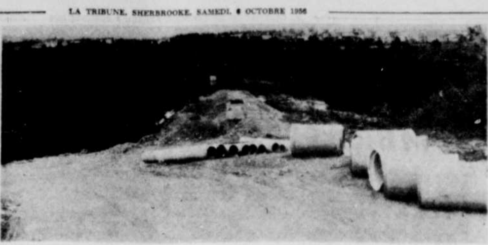
Nouvelle rue à Thetford. — La cité de Thetford Mines fait exécuter d'importants travaux d'aqueduc et d'égout dans la rue Simoneau jusqu'à la gare du Québec Central et l'hôpital St-Joseph.
