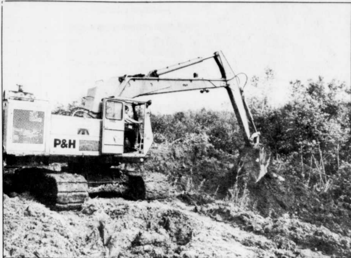
La firme Maskimo a entrepris des travaux de déblocage de la rivière Champlain, entre les rangs Saint-Joseph et Saint-Alexis hier. (Photo Yves Champoux)
