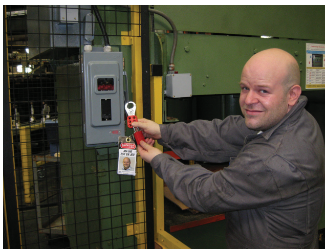
Cadenassage d'une installation électrique
