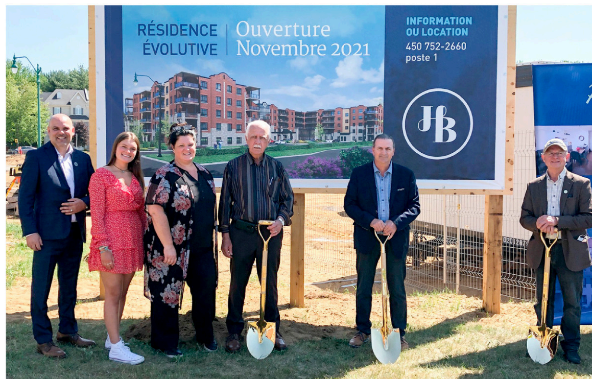
La résidence évolutive et intelligente des Habitations Bordeleau située au 125 Roméo-Gaudreault, à Joliette, dont la construction, totalisant 203 appartements, a officiellement débuté le 16 juin dernier. Elle est la première résidence pour personnes âgées à accueillir l'assistant Evey.
