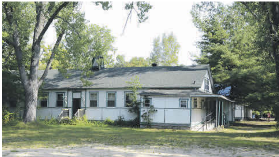
Plusieurs bâtiments de la Colonie des Grèves nécessitent des travaux.
