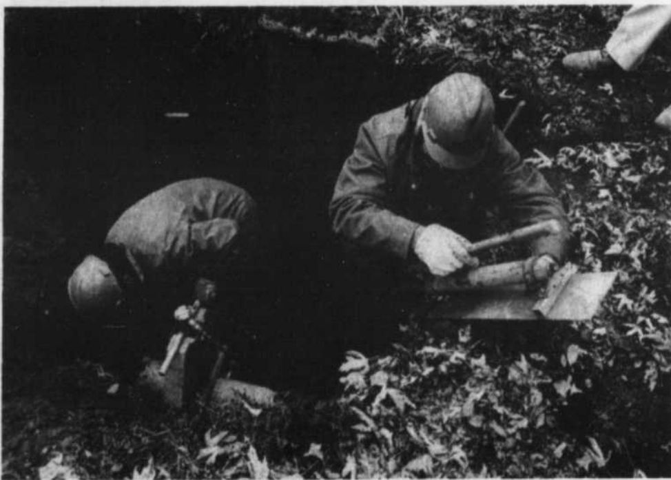
De l'autre côté de la rue, les techniciens de Gaz Métropolitain se sont affairés à étrangler la conduite avec un équipement spécial.
