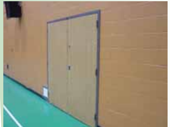
Le cadrage de porte est à égalité avec le mur et la poignée est encastrée. La quincaillerie a été ajustée afin que les portes ouvrent de l'intérieur.
