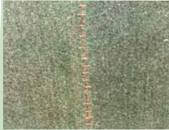
La réparation du gazon synthétique est inappropriée.
