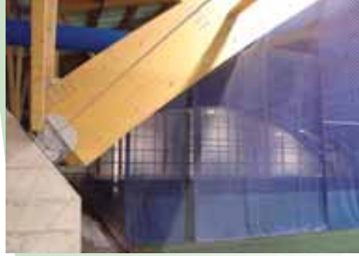
Complexe de soccer avec structure de bois lamellé
