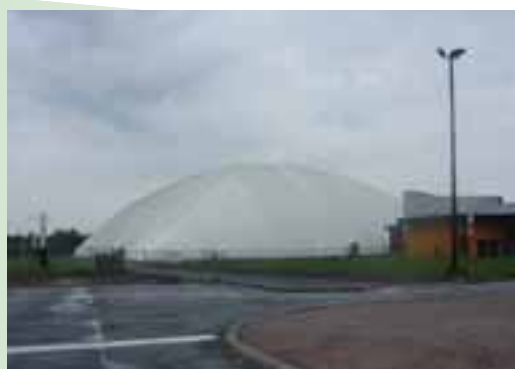
Une construction permanente pour les services est joutée à la structure.
