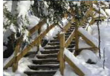
Aménagement au mont Saint-Grégoire
