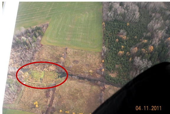
Photo 7. Vue rapprochée du marais filtrant
