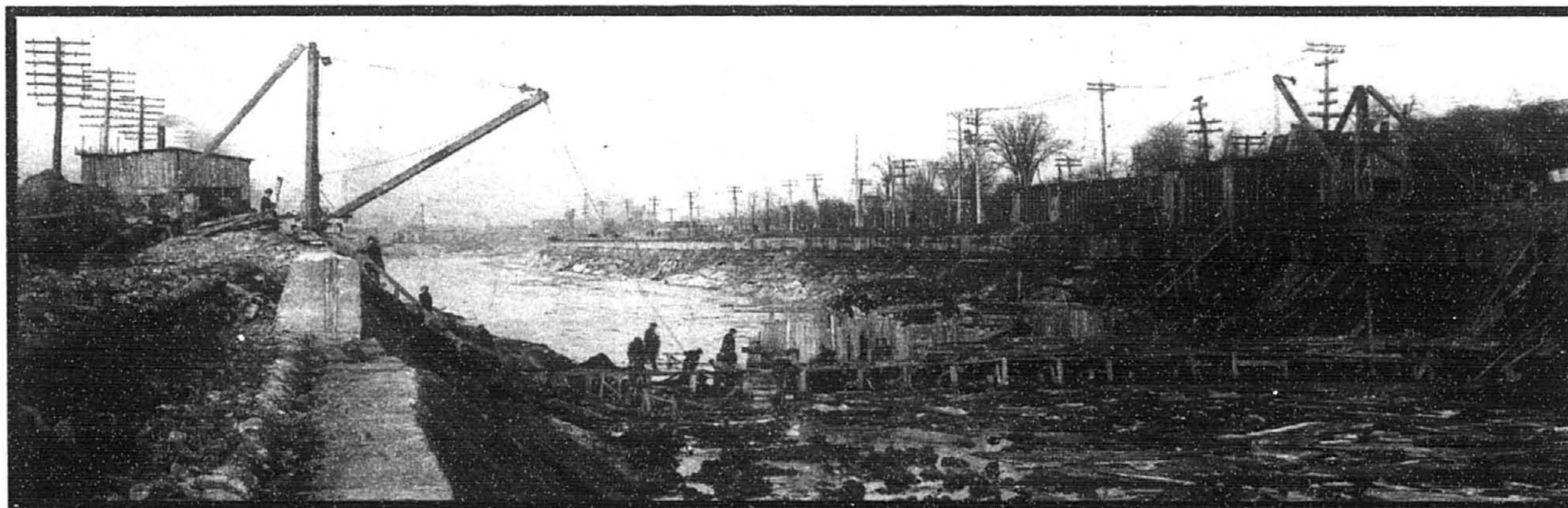
Des ouvriers s'affairent, en avril 1914, à la construction d'une conduite de gaz traversant le canal Lachine.
