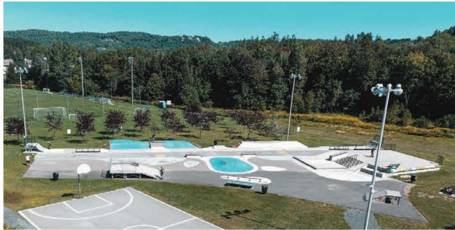
La Ville de Saint-Sauveur aimerait commencer les travaux du skatepark au printemps 2023.
