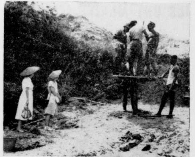
Mlle C. Simard et sa mère regardant fonctionner une foreuse à main servant à découvrir les lits de bauxite à la Guyane. On doit quelquefois forer jusqu'à une profondeur de 200 pieds.
