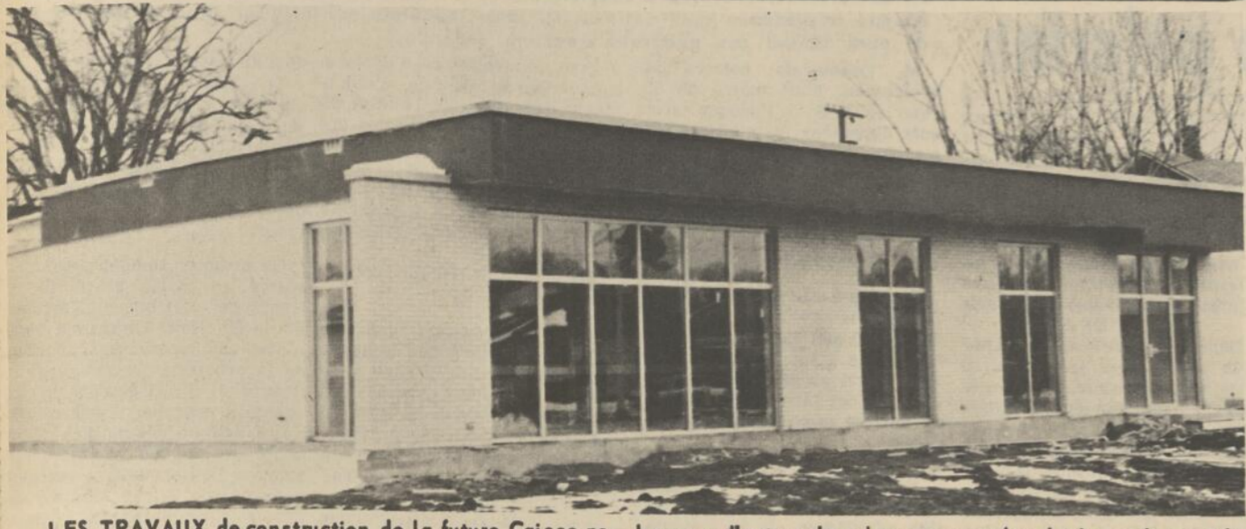
LES TRAVAUX de construction de la future Caisse populaire d'Iberville entrent dans leurs dernières phases. Dans quelques semaines, les employés de cette Caisse seront heureux d'entrer dans leur nouveau local très moderne. L'édifice est situé à l'angle de la 3e et de la 4e rues, à Iberville.
