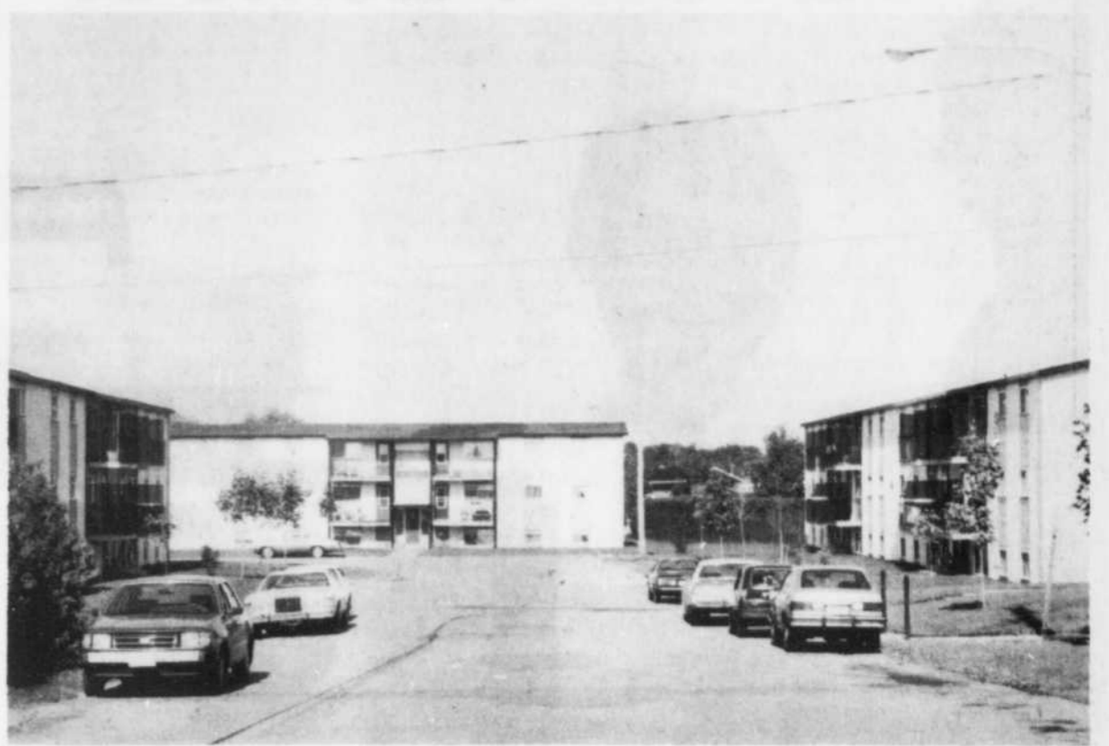
Sous une apparence plus que convenable, les édifices cachent de sérieux problèmes, qui nécessitent des travaux de plus de 700,000 $.
