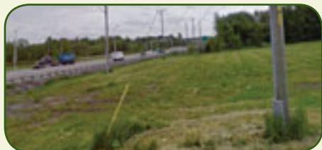
Travaux de trop-plein, intersection Principale Sud et route 132
