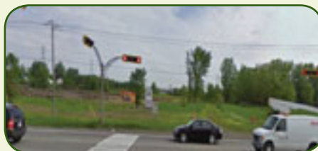
Travaux de construction du prolongement du boul. Georges-Gagné, phase I
