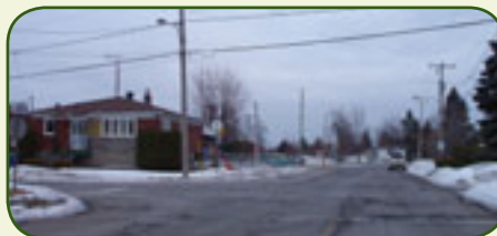
Travaux de réfection des infrastructures sur la rue Cusson, entre le boul. Georges-Gagné et la rue du Collège
