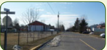
Travaux de revêtement de béton bitumineux de 2 e couche, rue Lapalme
