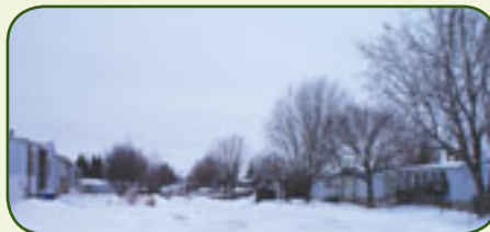
Travaux de réfection de certaines infrastructures rue Carignan, entre la rue de Canora et le boul. Georges-Gagné
