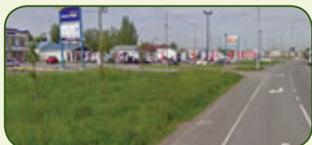
Travaux de remise en état des lieux suite aux travaux d'aqueduc route 132
