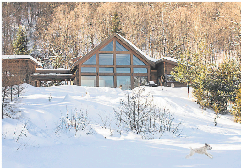
Le chalet de la famille Thibodeau est situé à La Macaza, dans les Laurentides. Le bâtiment tombait en ruine quand Sylvain a décidé de le rénover. C'est sa sœur Nathalie, architecte, qui a dessiné les plans. — PHOTOS LA PRESSE, OLIVIER PONTBRIAND
