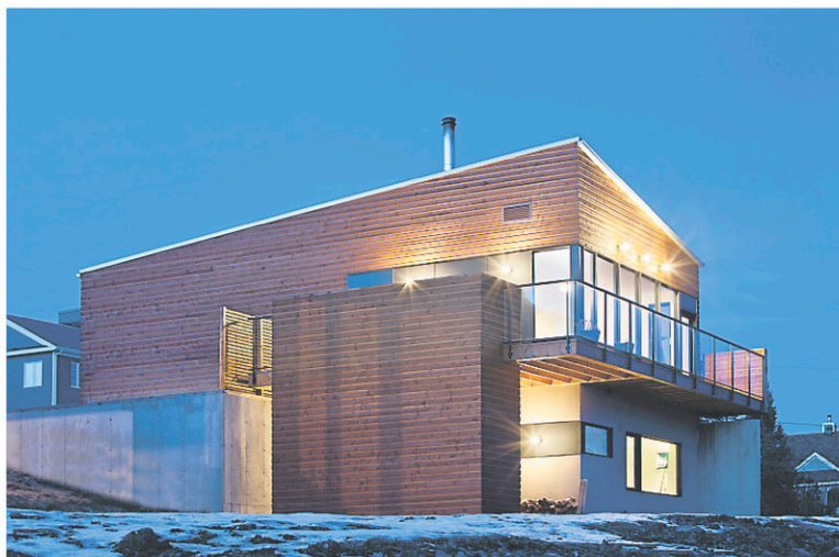
Dans 20 ans, Julie Dubé aimerait voir davantage de maisons plus compactes. Voici un projet de BISSON | associés, la résidence Dumas Chouinard, qui démontre cette pensée. — PHOTOS FOURNIES PAR STÉPHANE GROLEAU
