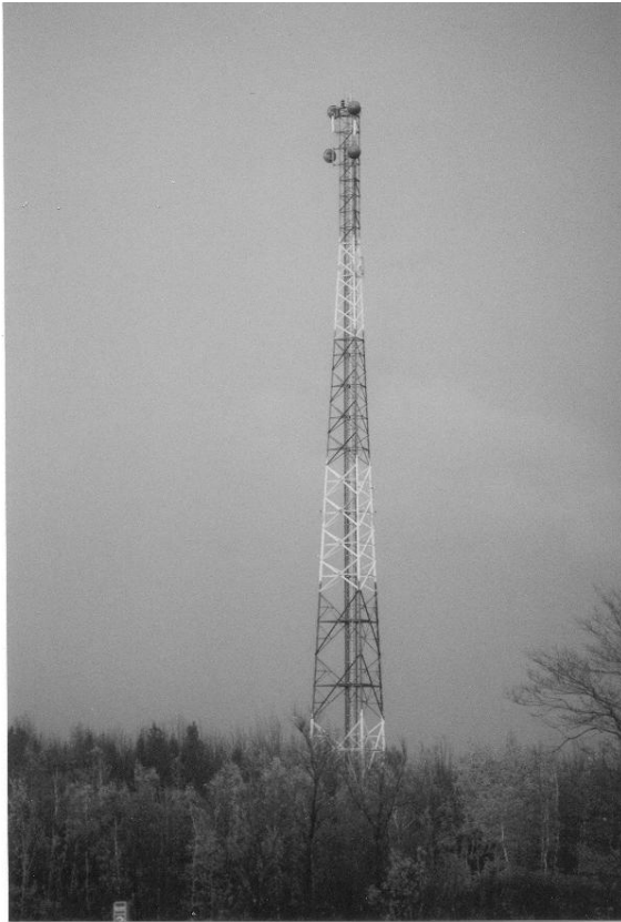
Figure 31. Les tours sans haubans sont considérées moins dangereuses pour les oiseaux migrants.
