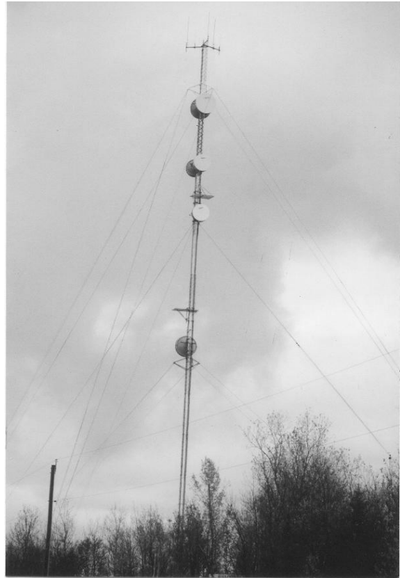
Figure 32. Les tours avec haubans seraient plus résistantes au verglas.
