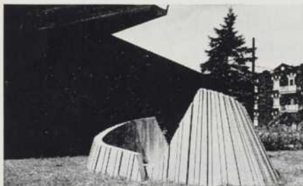
Puits et gouttière en béton monolithique.
