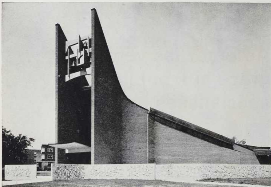
Extérieur d'aspect moderne: un toit parabololoïde hyperbolique en béton.
