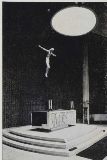
Autel de conception exceptionnelle, en béton à fini bouchardé.
