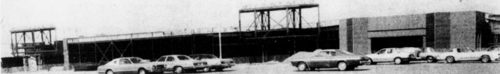
Interrompus pour les vacances de la construction, les travaux de construction aux Galeries Quatre Saisons devraient être complétés vers la mi-septembre.
