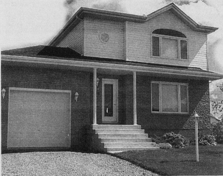
Des constructions de qualité, de même qu'un choix honnête et fiable. Voilà ce que proposent aux acheteurs de maisons neuves les Entreprises Laurent Labrie.
