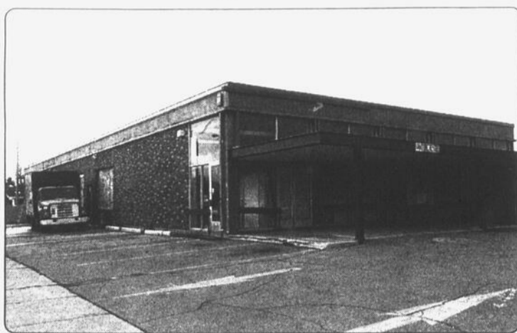
Les travaux ont déjà commencé au Centre Dorchester, sur le mur où sera située l'entrée du bureau de la Société de la faune et des parcs, rue Lebeau.
