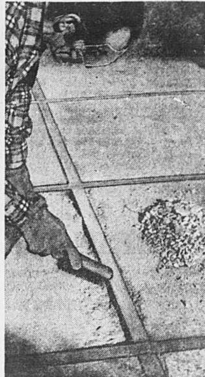
La surface est brossée puis balayée afin qu'il ne reste aucune poussière.
