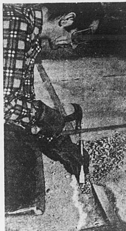
Les yeux, les mains et les genoux protégés, on enlève au ciseau les parties désagrégées du béton.
