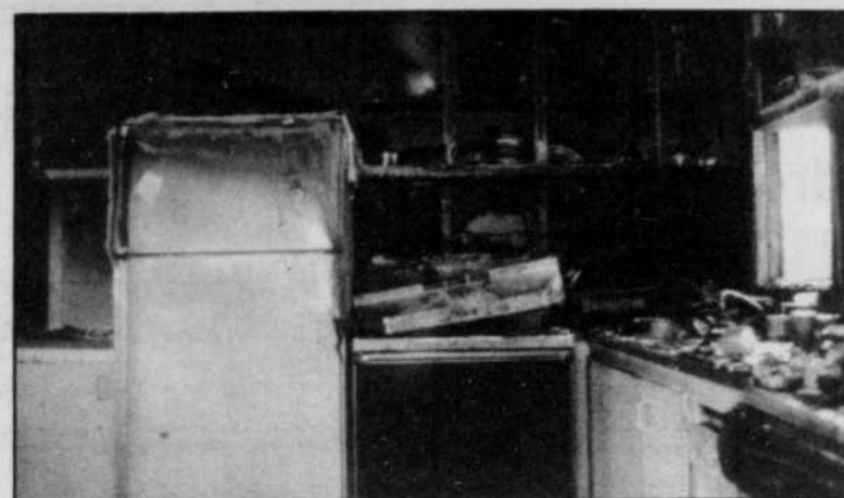
Voici ce qui reste de la cuisine de la maison mobile située au 687 route 137, qui a été la proie des flammes hier.
