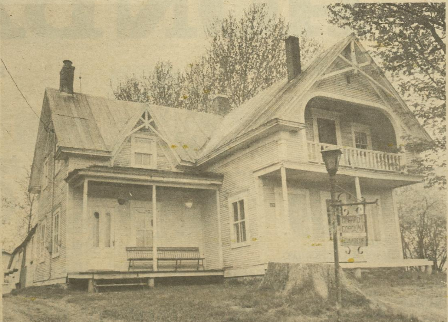
La maison de Gérard Cordeau date d'un siècle environ et elle pourrait avoir appartenu au propriétaire d'un moulin ou d'une tannerie.
