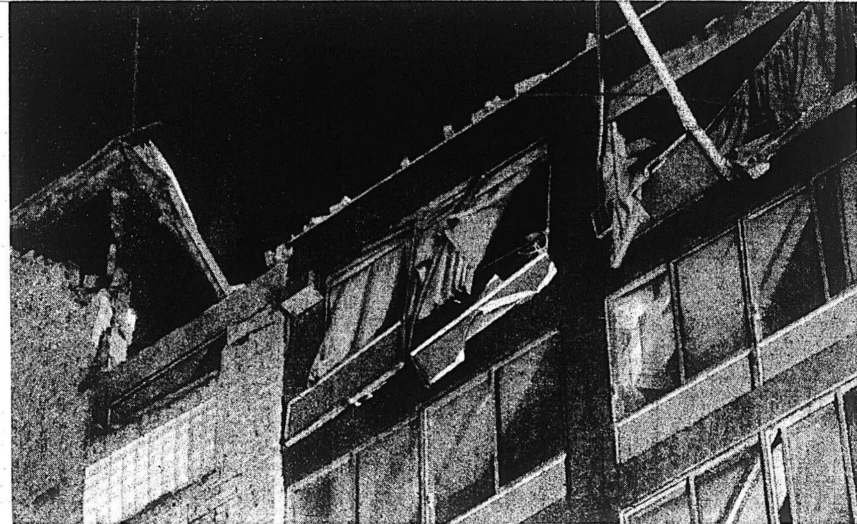
Les locaux de la délégation commerciale cubaine, située au 12 e étage d'un immeuble, au 3737 est, boulevard Crémazie, ont été fortement endommagés, tôt ce matin, par l'explosion d'une ou plusieurs bombes.
