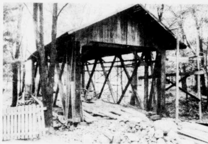
Déménagé pièce par pièce depuis les Cantons de l'est, le pont couvert du Village d'antan est en bonne voie de reconstitution.
