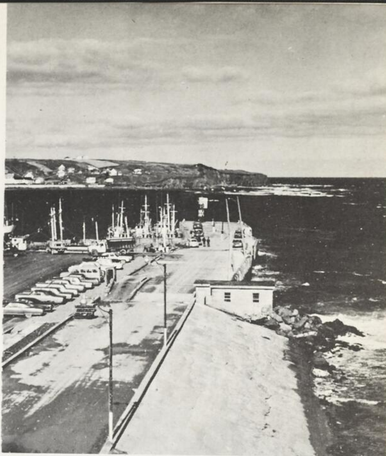
Partie des quais et station de pompage
