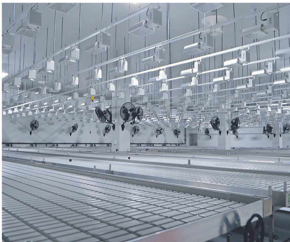
Chaque salle de floraison disposera de 128 lumières de 1000 watts qui seront en opération douze heures par jour.
