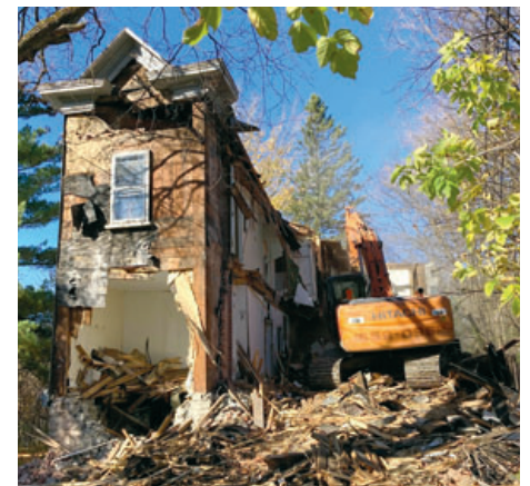
La démolition de la maison de deux étages de la famille Bélanger a débuté vers 13 h et l'incendie s'est produit alors que le bâtiment avait été réduit à un gros amas de bois sec et de débris de construction un peu plus tard dans l'après-midi. (Photo : Michel Bédard)
