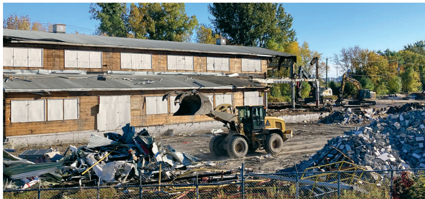
Tous les bâtiments de l'entreprise Sico fondée en 1937 ont été démolis au cours des dernières semaines. (Photo : Michel Bédard)
