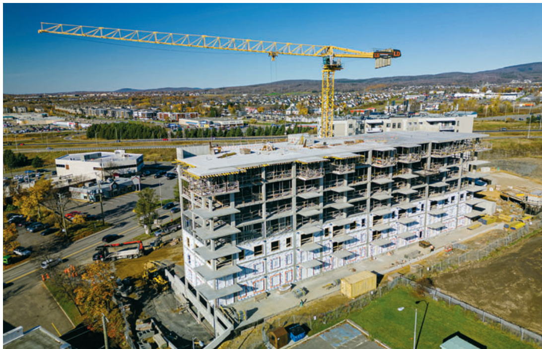
Réalisés par Gestion Laberge inc, les travaux de construction s'échelonnent jusqu'au printemps prochain pour une ouverture en juillet 2023 sur le site voisin du Plateau des Dominicaines, un immeuble propriété du Groupe Laberge depuis déjà une trentaine d'années. ( Photo : gracieuseté Groupe Laberge)
