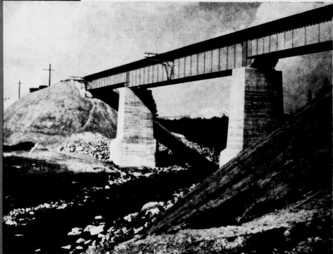
Pont de chemin de fer construit sur la rivière Thetford pour la Compagnie Quebec Central Railway.
