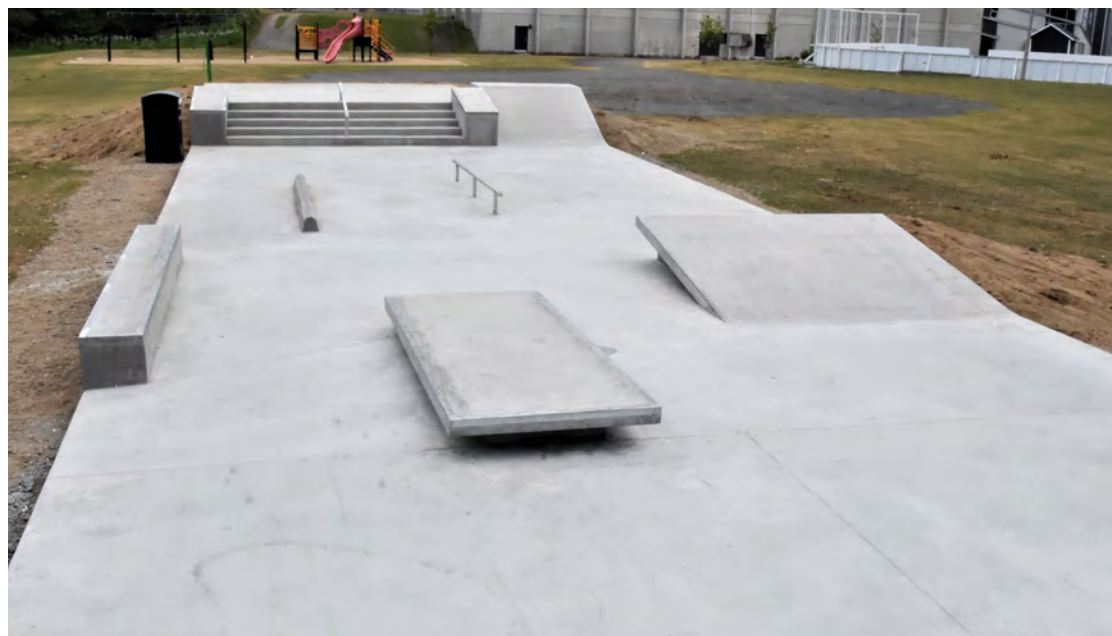
Le skatepark est déjà en place à côté de l'École secondaire du Plateau.
