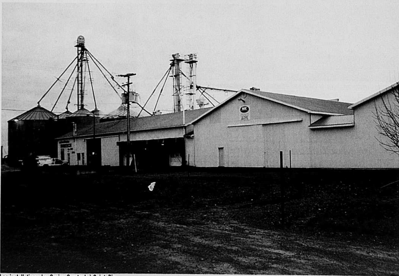
Les installations des Grains Semtech à Saint-Pie
