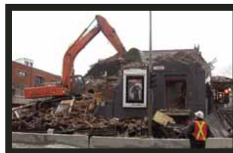
Démolition du Théâtre de Quat'sous avant reconstruction, février 2008 © Eric Jean
