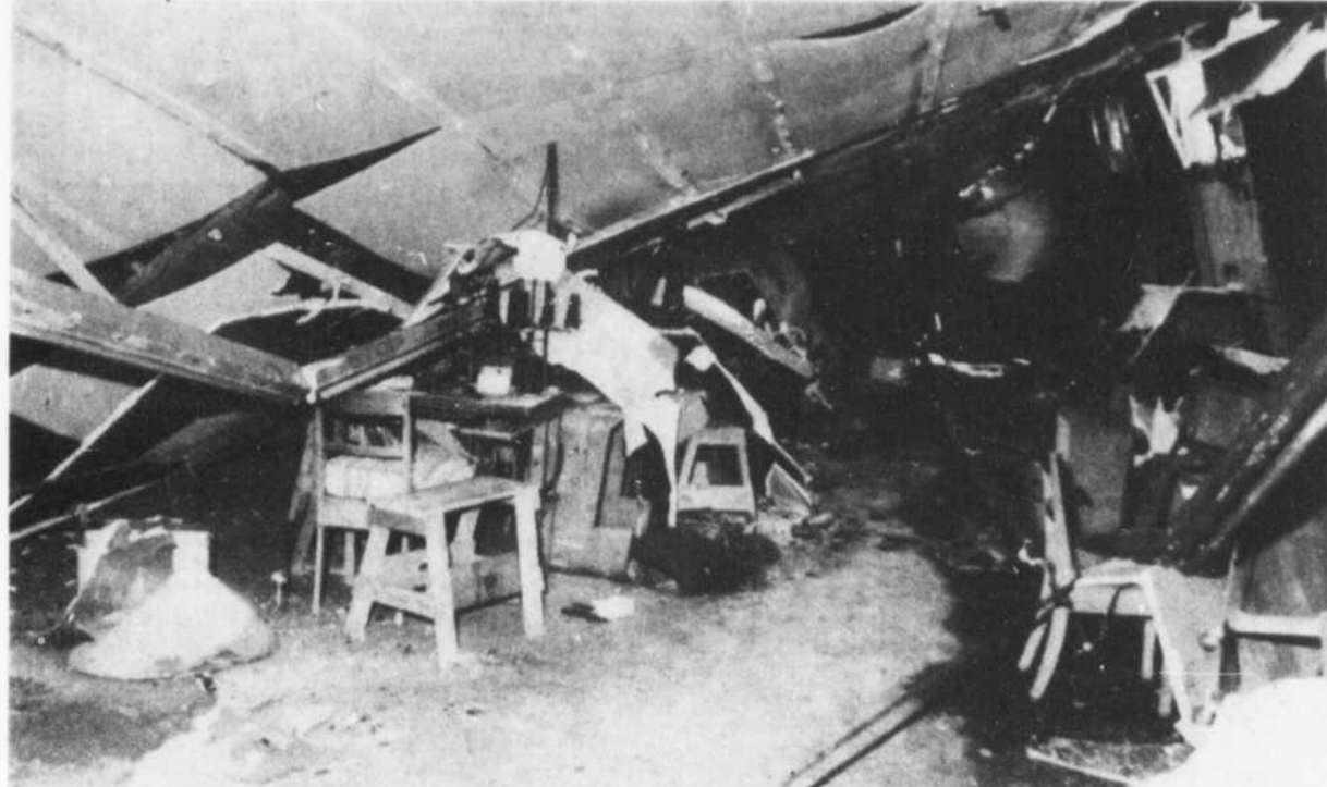
Ce qui reste de l'intérieur de la manufacture à Rock Forest, le plafond à demi effondré et les murs risquant de tomber. (Photo La Tribune par Daniel Forgues)
