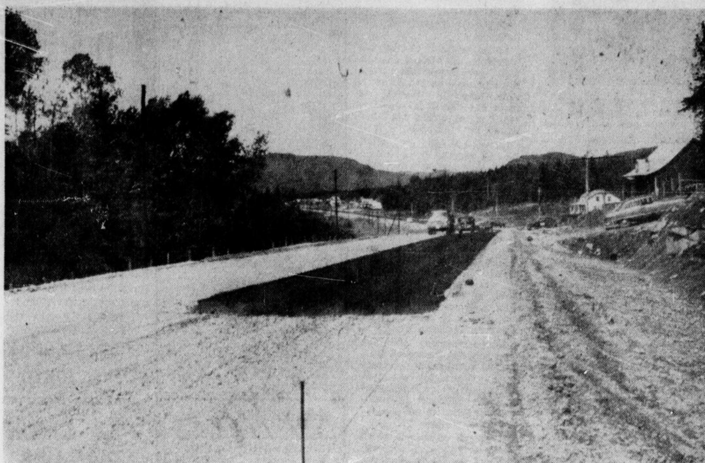
TRAVAUX DE VOIRIE A STONEHAM: Le tronçon de route qui relie Québec et la banlieue au boulevard Talbot est, ce temps-ci l'objet, d'une réfection considérable de la part du ministère provincial de la Voirie. Ci-dessus, on peut voir que les cantonniers ont commencé à étendre une couche d'asphalte sur le nouveau parcours de la route, dans la municipalité de Stoneham. (Photo de "L'Événement-Journal")
